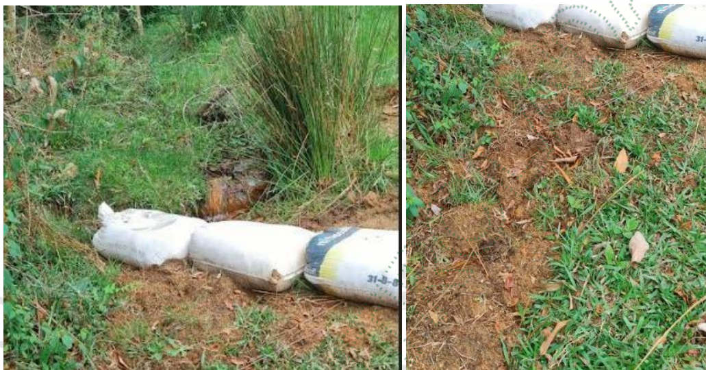
Imagen 1. Sellamiento acequia de la fuente El Coral Imagen 2. Restauración canal artificial
