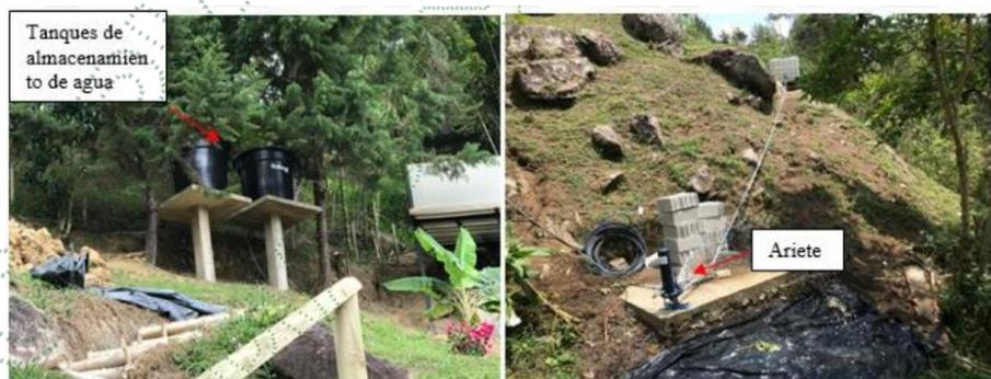
Figura 2. Tanque de almacenamiento y ariete
