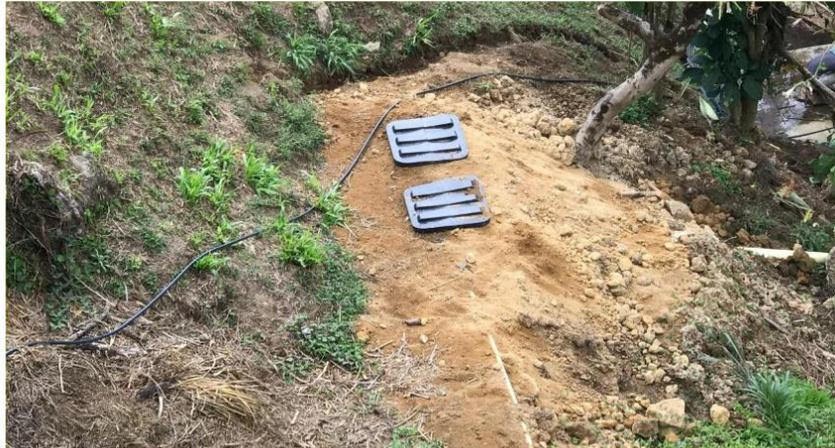
Figura 3. Tanque séptico para tratamiento de aguas residuales
