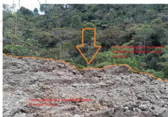
Figura 2: Imagen donde se evidencia el depósito de tierra removida, a escasos 10 m con relación a la fuente hídrica.
