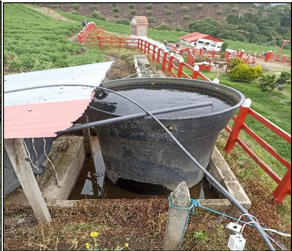
Tanque Álvaro Ocampo sin control flujo ni flotador
