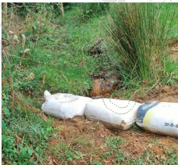
Imagen 1. Sellamiento acequia de la fuente El Coral artificial
