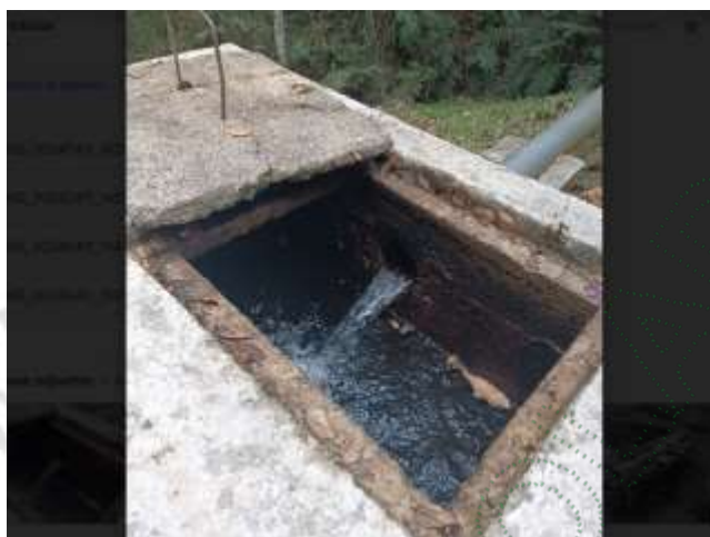
TANQUE DESARENADOR PUNTO 1 LA LAJA
