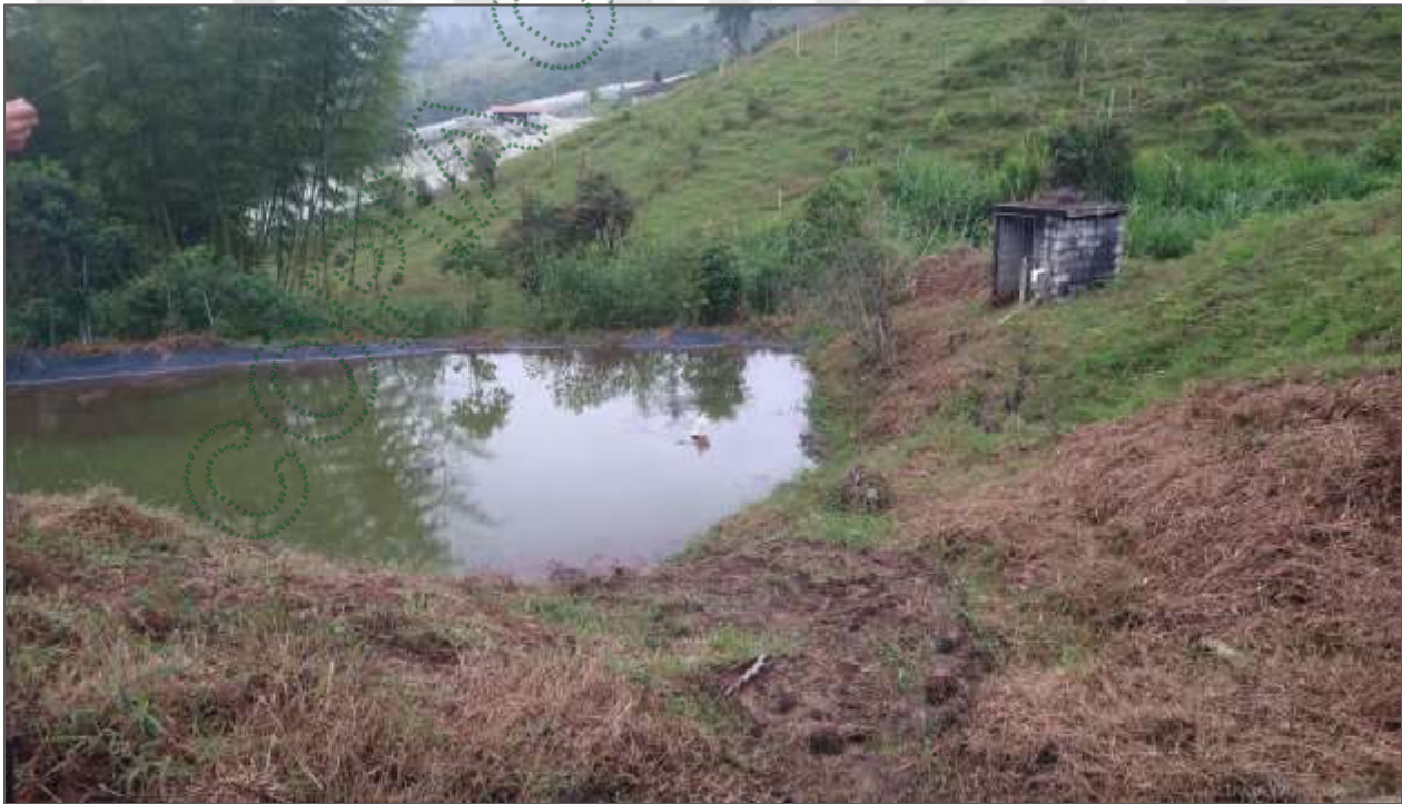
Foto 4. Reservorio 1 y Caseta de bombeo
