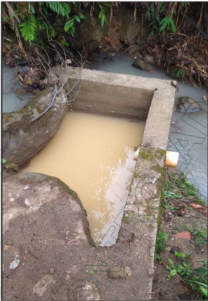
Foto 3. Obra de captación existente sin operar actualmente
