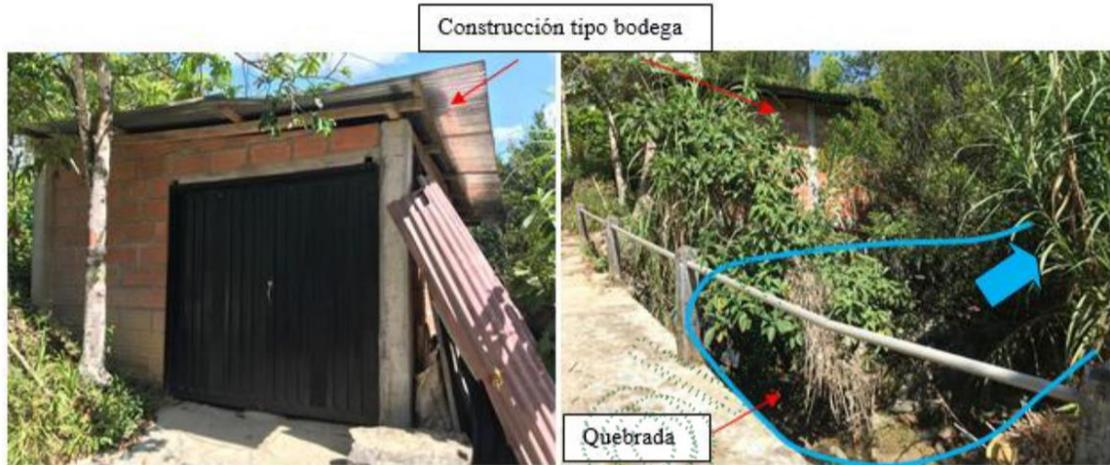
La construcción se encontró cerrada, y se logró evidenciar en la parte trasera de dicha construcción una manguera 2". Cuya descarga se realiza directamente a la quebrada, posiblemente de una unidad sanitaria y cocina.
