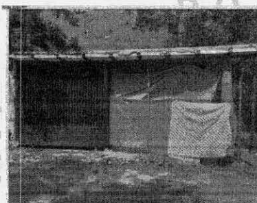
Fotografía 1. Parte frontal de la construcción, ubicada en el predio con FMI: 026-0014574, vereda Fátima-Concepción.
