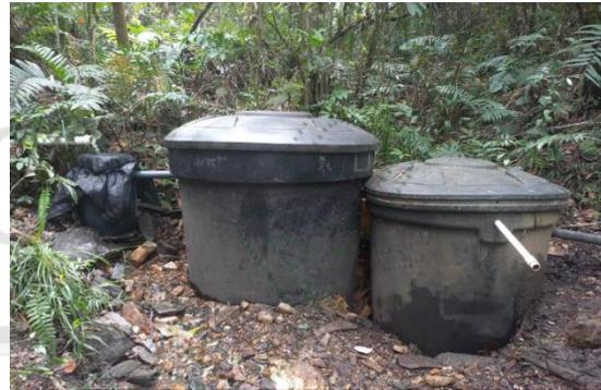
En el tubo que pasa el agua al segundo tanque se realizó aforo volumétrico, observando que se está derivando un caudal de  $0,124\text{L/sg}$ , caudal similar al otorgado por Cornare. De esta fuente se otorgó  $0,166\text{ L/sg}$ . ver tabla de aforo.
