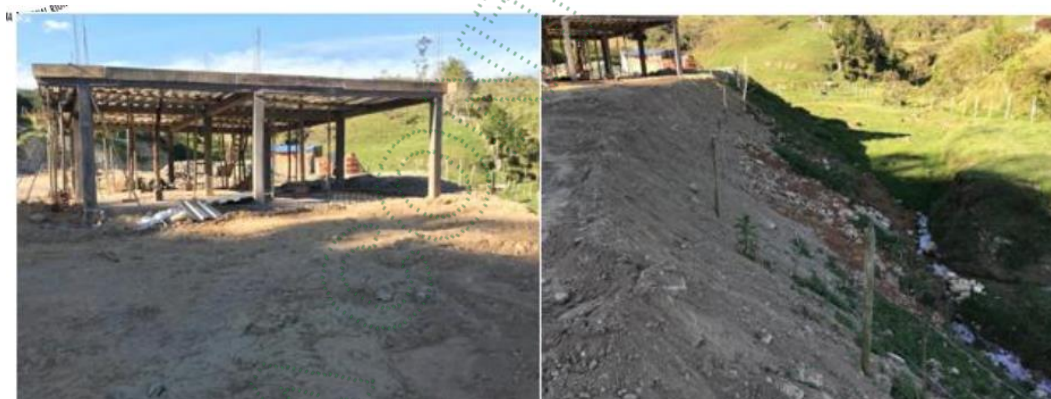
Figura 2. Estado del predio al momento de la verificación en campo.
