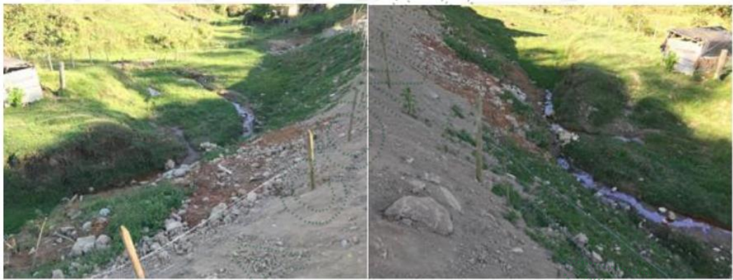
Figura 3. Estado del predio al momento de la verificación en campo
