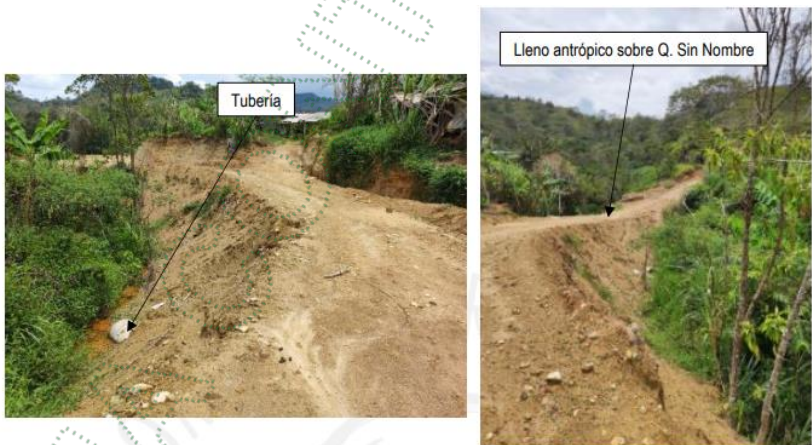
Foto 1. Lleno antrópico y tubería en el cauce de la quebrada Sin Nombre. Fuente: Cornare, 2024.
