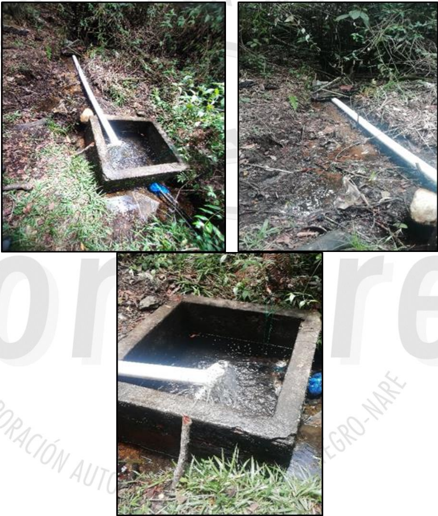
Imágenes 3, 4, 5: Obra de captación aguas arriba
