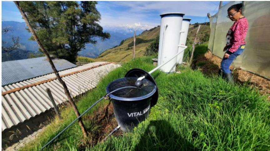
*Tanque con flotador en mal estado con desperdicio de agua*
