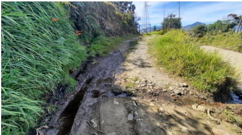
*Remanente de agua a carretera después del tanque de almacenamiento sin control de flujo*
