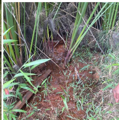
Figura 6. Fuente Los Lagos (Captación).
