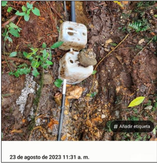
Imagen 3. Obra captación y control de caudal fuente “La Selva”
