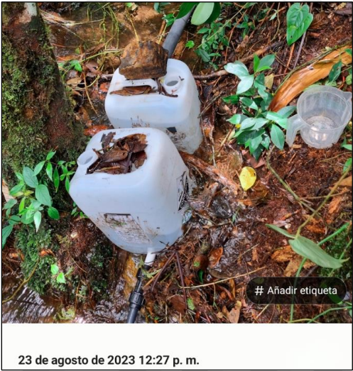
Imagen 5. Obra captación y control de caudal fuente “Guadarrama”
