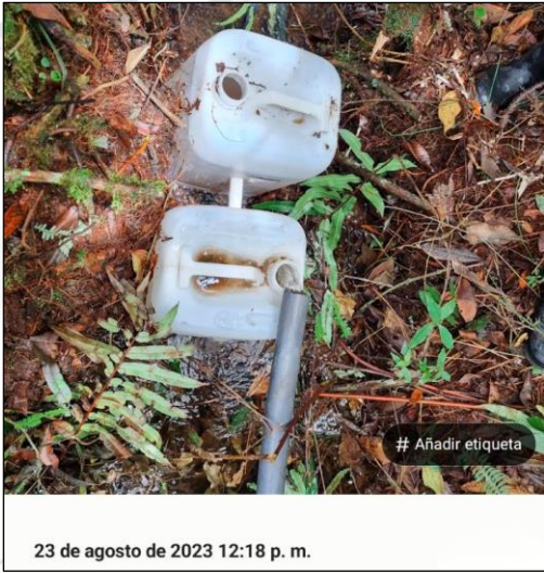
Imagen 4. Obra captación y control de caudal fuente “Guacimal”
