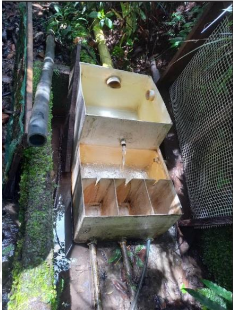
Imagen 2. Obra de captación y control
