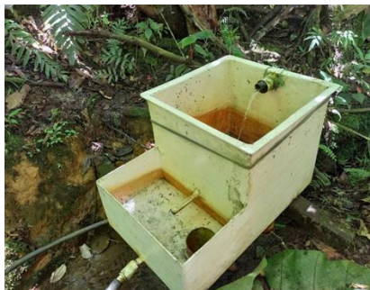
Imagen 1. Obra de captación y control
