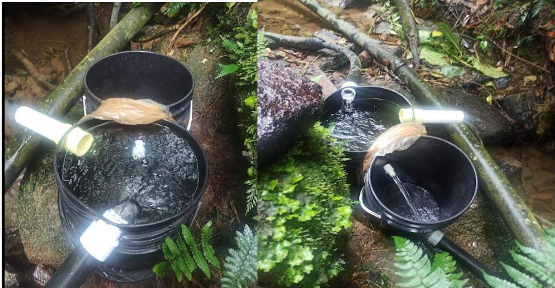
**Imagen 2. Obra de captación y control de caudales fuente hidrica "La Manuela"**
