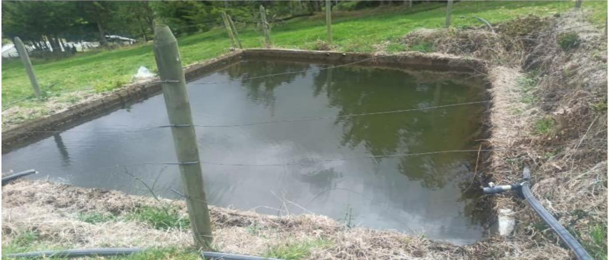
Imagen 3. Tanque de almacenamiento en mampostería de 30000 L de Capacidad aproximadamente.
