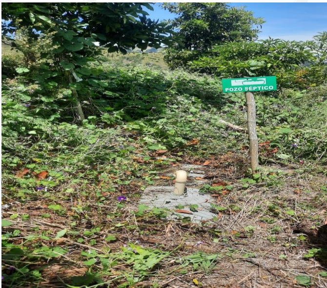
Pozo séptico para ARD en la vivienda
