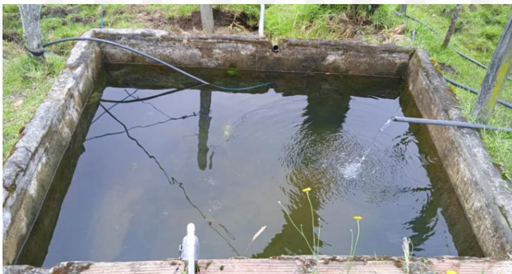
Imagen 2. Tanque de almacenamiento en mampostería de 2000 L de Capacidad
