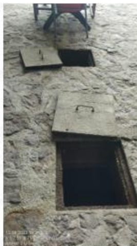
Imagen7. Sedimentador y FAFA
