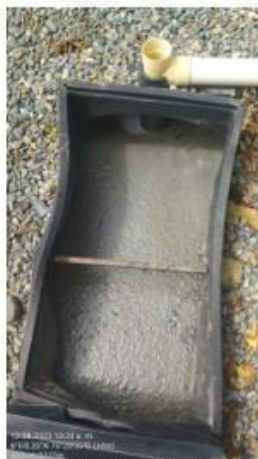
Imagen9. Sedimentador STARD.
