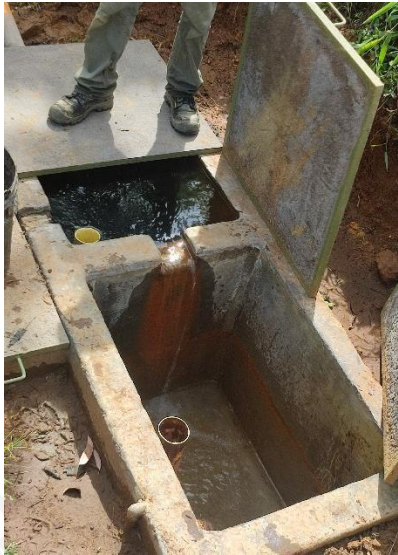
Figura 1. Obra de control de la fuente San Rafael 1
