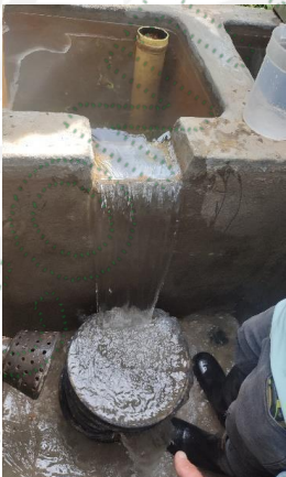
Figura 2. Obra de control de la fuente San Rafael 2
