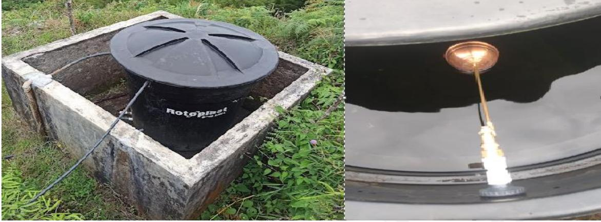
Imagen 2. Tanque de almacenamiento de 2000 L con el flotador respectivo.
