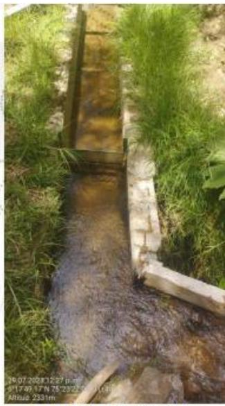
Imagen4. Obra de captación y derivación.
