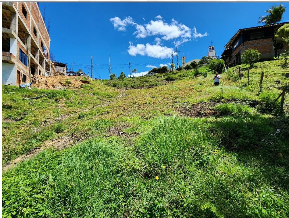
Predio donde se va a realizar la construcción del Mall Las Partidas.
