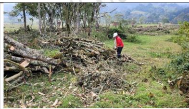
Foto 4. Cerramiento con cinta para evitar accidentes
