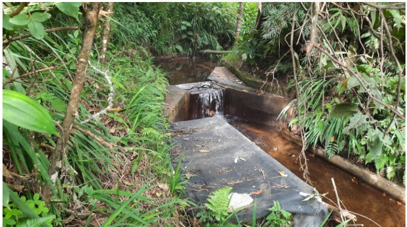
Obra de captación estable y sin sedimentación
