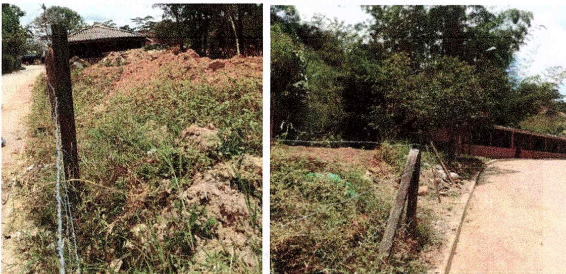
Fotografía 7. Llenos antrópicos alledaños al lleno de la feria. Fuente: CORNARE (10/08/2023)
