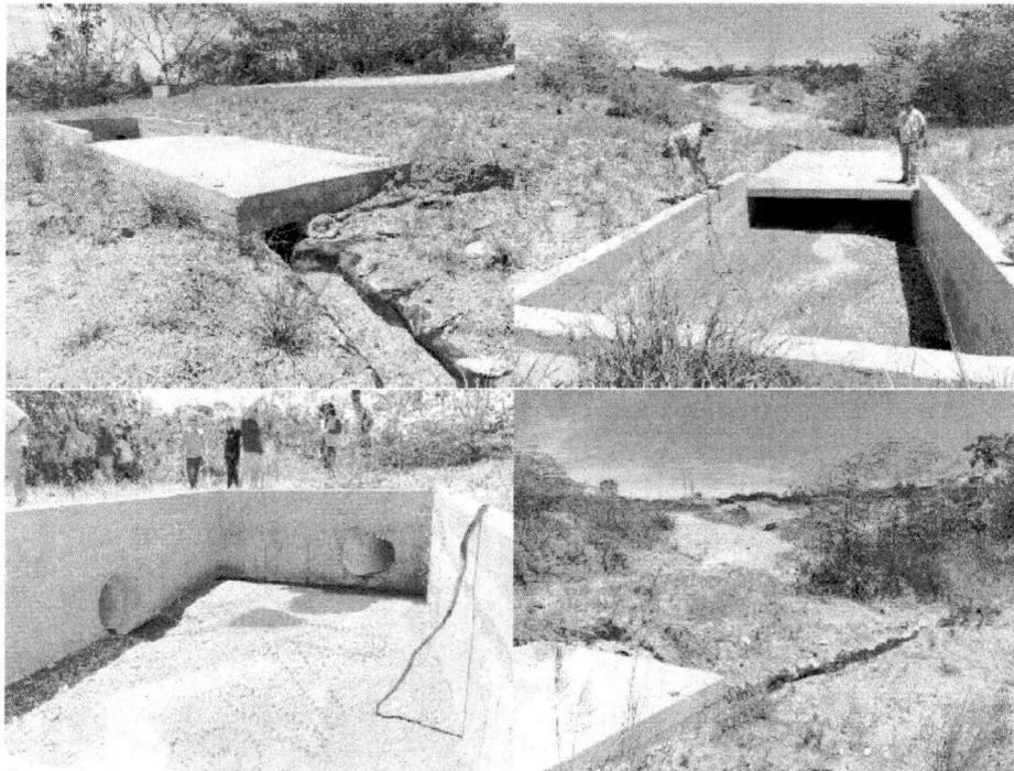
Foto 4, 5, 6 y 7. Desarenador implementado en la EDS Distracom. Fuente: Cornare, 2023.
