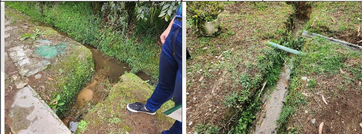
Descarga actual con zanjas en tierra, **proyecta entubarse con descarga directa a la fuente con difusor sumergido.**
