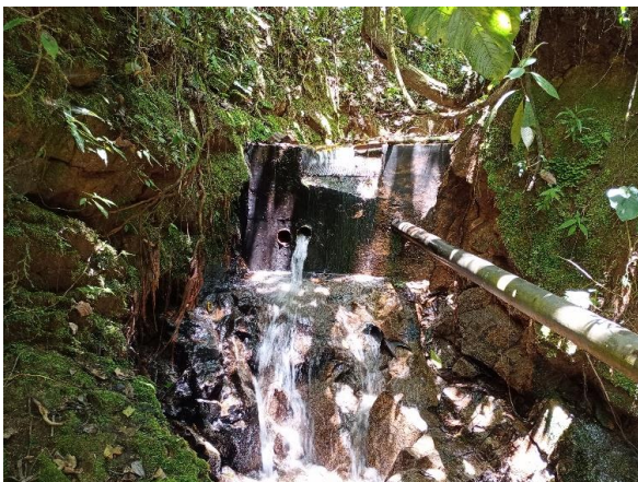
Imagen # 2 estructura de captación
