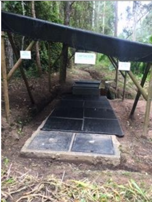
Imagen 2: Obra de Captación y Control de Caudal fuente "PAIMADO"
