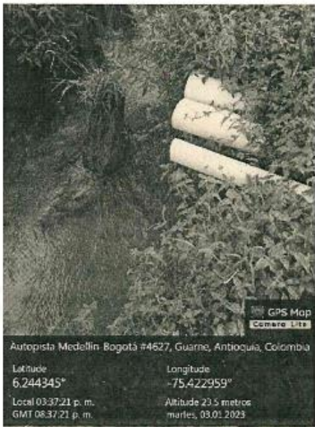
Imagen 1. Estructura de descarga. Imagen tomada de CE-02990-2023.
