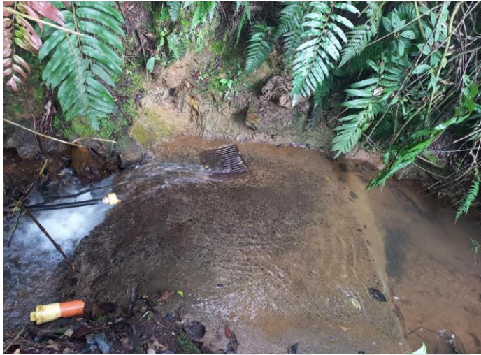
Imagen 2. Obra de captación artesanal
