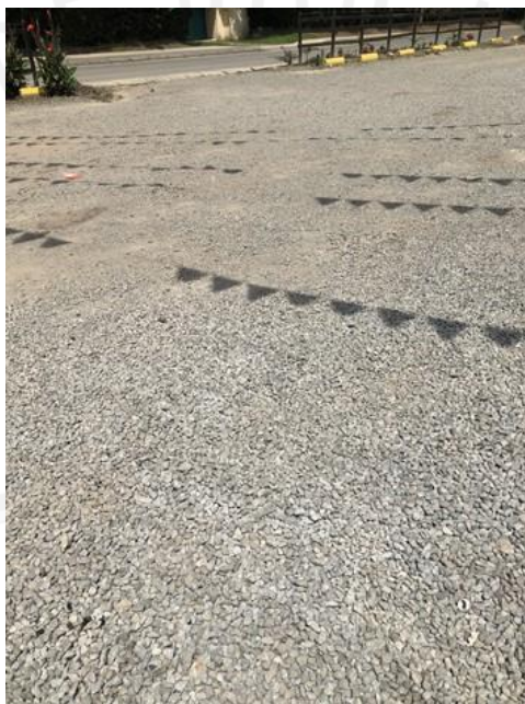
Ubicación campo de infiltración
