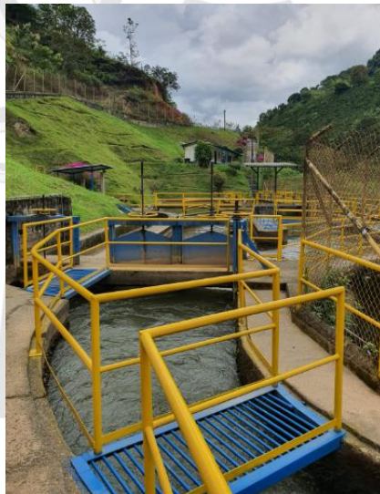
Canal de aducción
