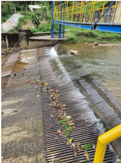
Azud y rejillas
