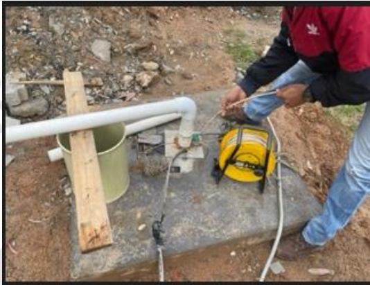
El recurso hídrico se capta del pozo a través de una motobomba tipo lapicero
