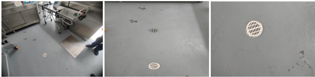
Implementación de sistema de rejillas-sifón
