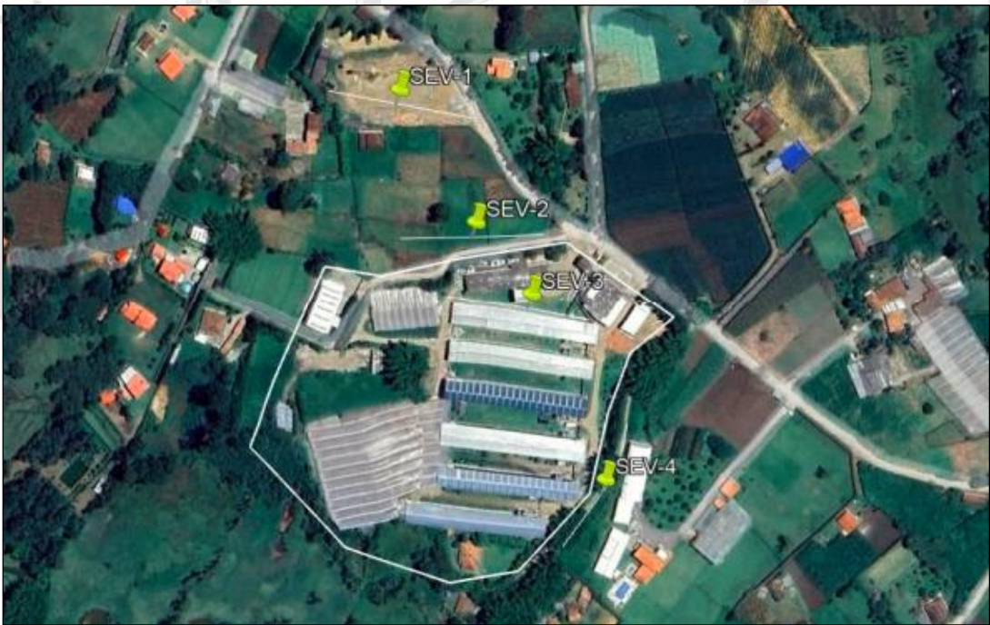
Imagen 2. Zona de exploración para la construcción de los pozos en Avícola San Martín. Fuente: Tierras y Suelos.
