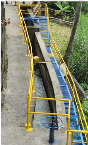
Canal de aducción
