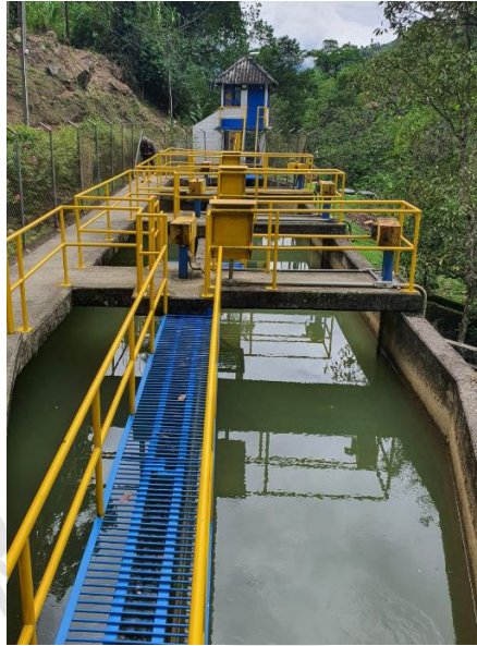
Fotografía 4. Desarenadores Fuente: CORNARE, 2023
