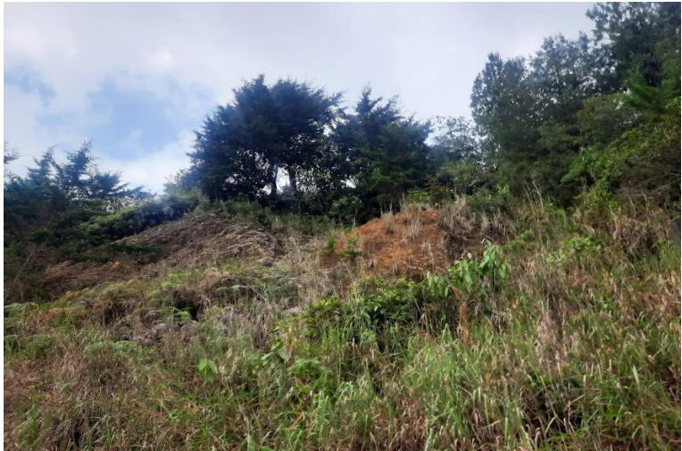
Taludes estables con procesos de revegetalización.
