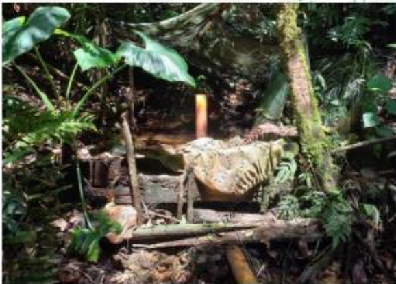
Imagen 1. Obra de Captación artesanal
