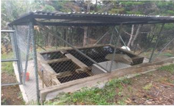
Imagen 1. Tanque de almacenamiento
