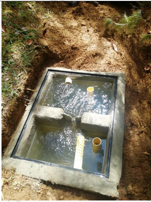
Imagen 4: Obra de control de Caudal Fuente Sin Nombre
