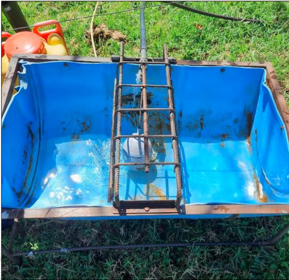
Imagen 2. Mecanismos control de caudal para el predio con FMI 017-65867
