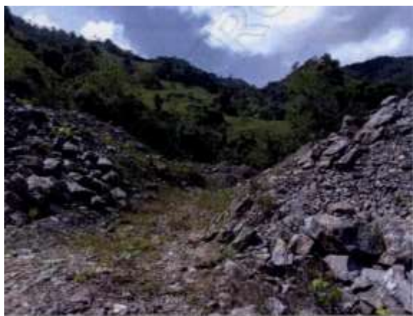
Fotografía 1. Taludes en patio de cargue. Fuente: CE- 02697-2023
