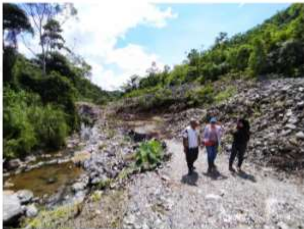
Fotografía 2. Taludes desprovistos de medidas de manejo. Fuente: Informe técnico IT-07640-2022 del 1 de diciembre de 2022.
