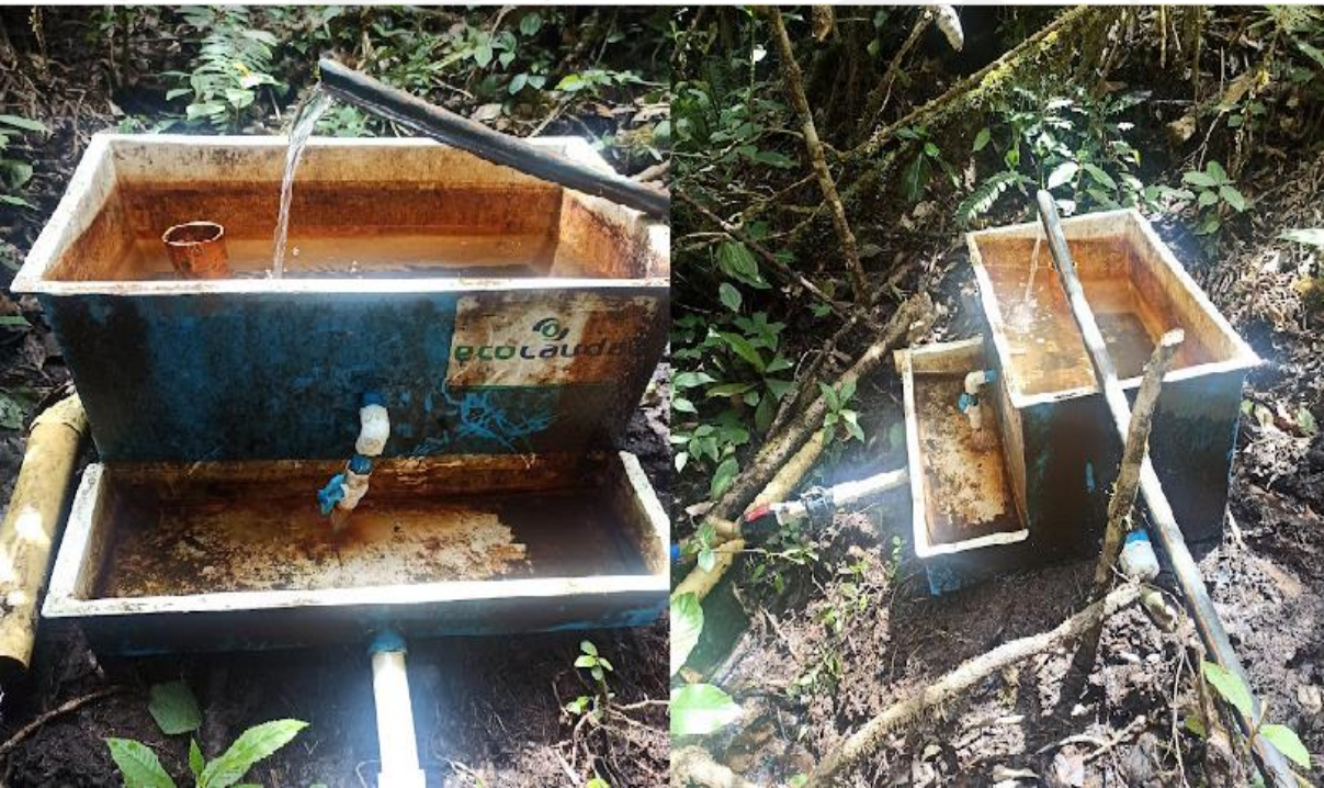
Imagen 2. Obra de captación y control de caudales verificada en campo
