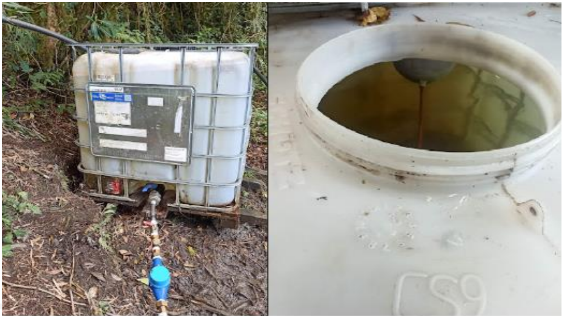
Imagen 3. Sistema de almacenamiento con flotador instalado
