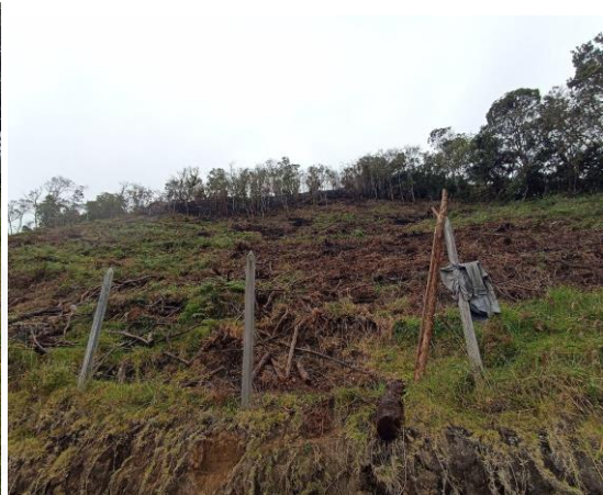
Ingreso al lote afectado
