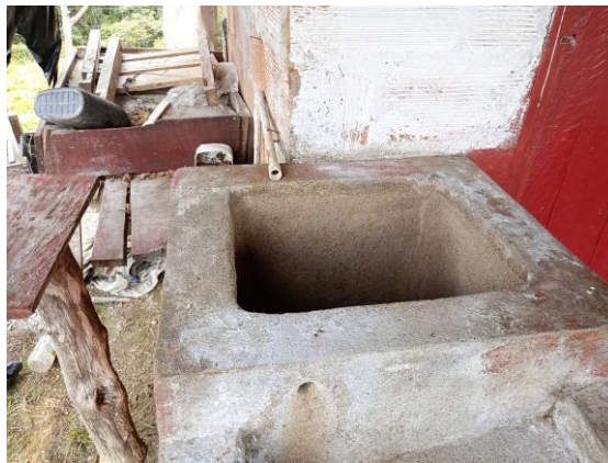
Tanque de almacenamiento fuera de servicio
