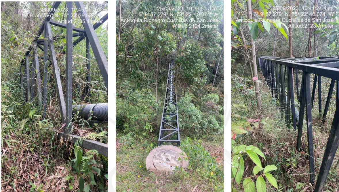
Viaducto Proyecto Arándanos – Q Sin Nombre.
